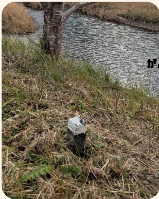
14条地図作成 基準点設置作業
