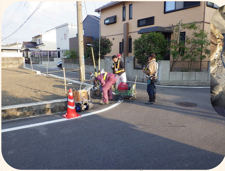
14条地図作成 基準点設置作業
